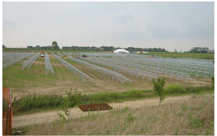
L'avanzamento dei lavori alla costruenda centrale fotovoltaica
