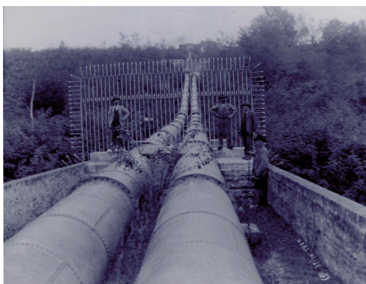
La condotta premente e la condotta discendente per l'elevazione dell'acqua nel canale consorziale
