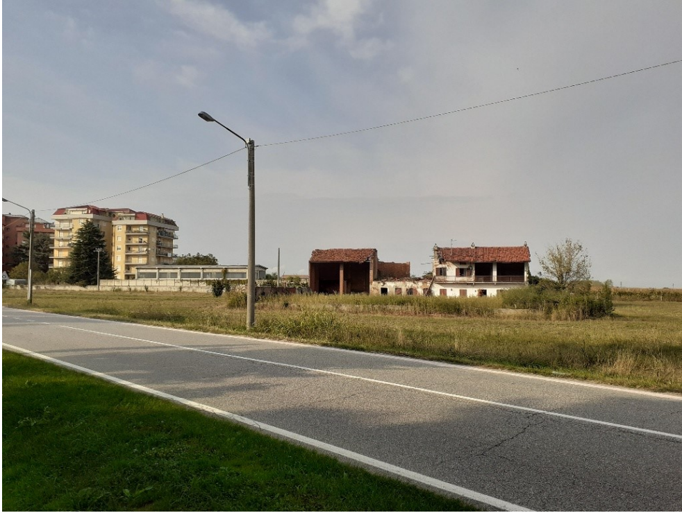
Vista della cascina da demolire, insistente sul mappale 281
