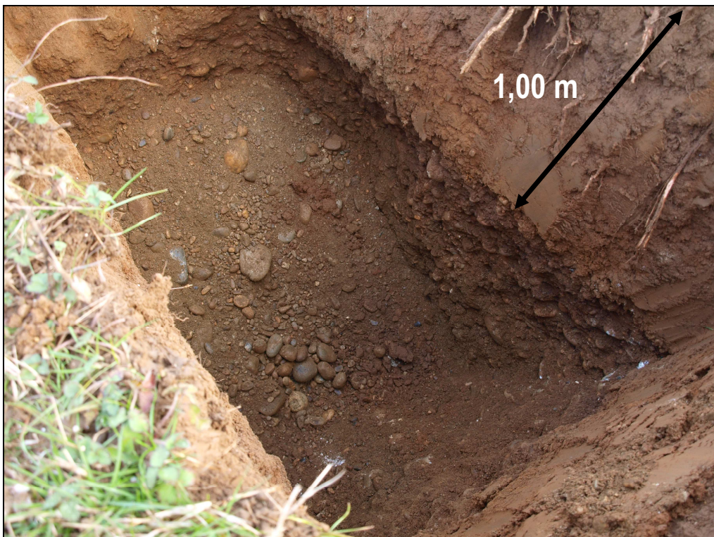
Foto 3 – Sezione dello scavo geognostico Sc1
